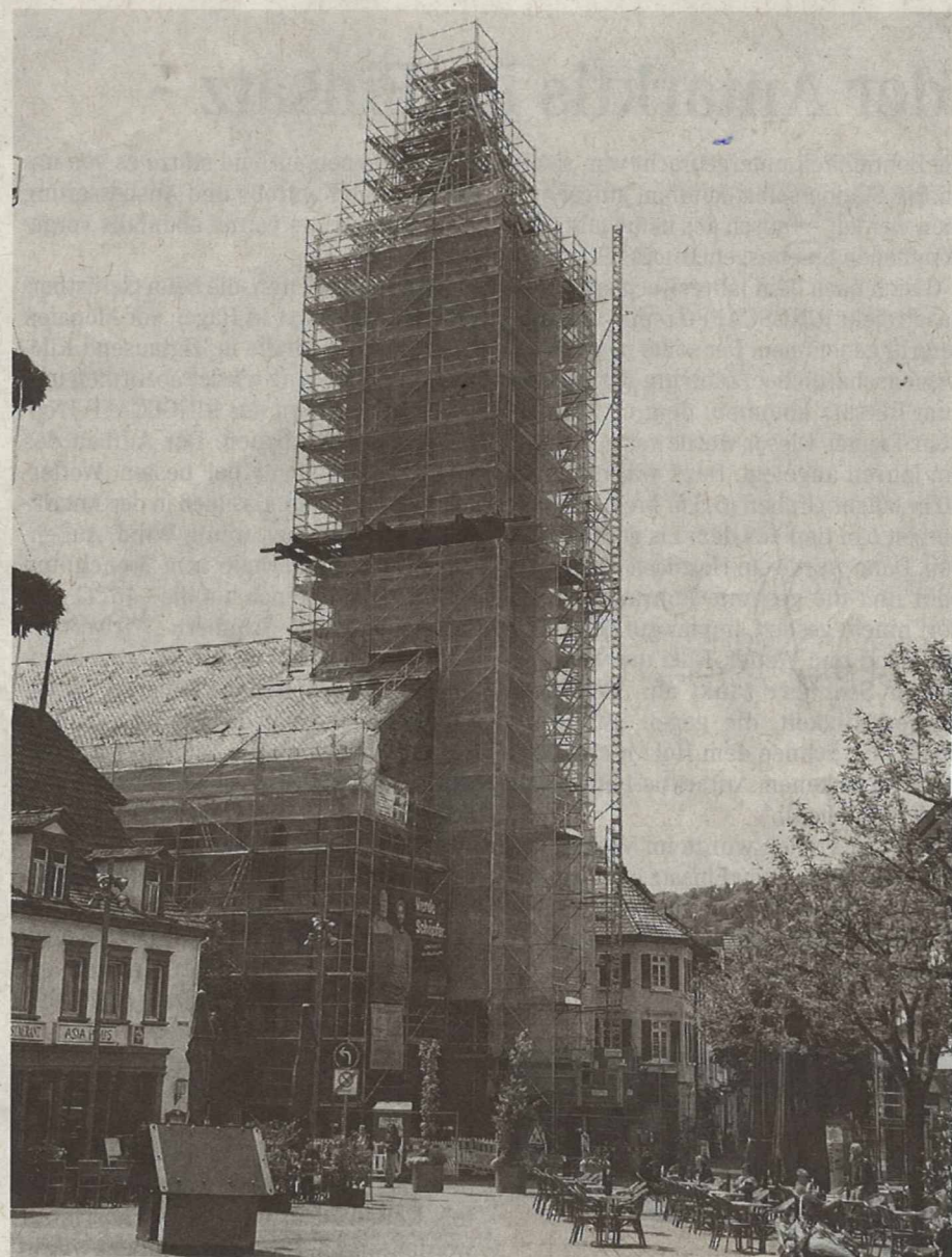
Der im 19. Jahrhundert aus Odenwälder Buntsandstein errichtete Kirchturm der evangelischen Hauptkirche in Eberbach ist zu restaurieren. FOTO: RJ GERÜSTBAU + ZUGANGSTECHNIK
